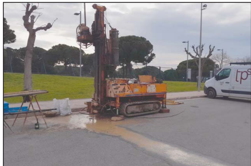
Fotografia 1. Vista de l'emplaçament de la màquina per a la realització del sondeig a rotació amb bateria continua S-6.
