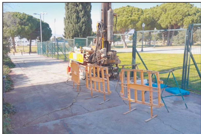
Fotografia 1. Vista de l'emplaçament de la màquina per a la realització del sondeig a rotació amb bateria continua S-8.
