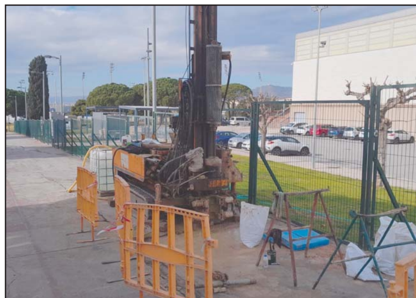
Fotografia 1. Vista de l'emplaçament de la màquina per a la realització del sondeig a rotació amb bateria continua S-9.
