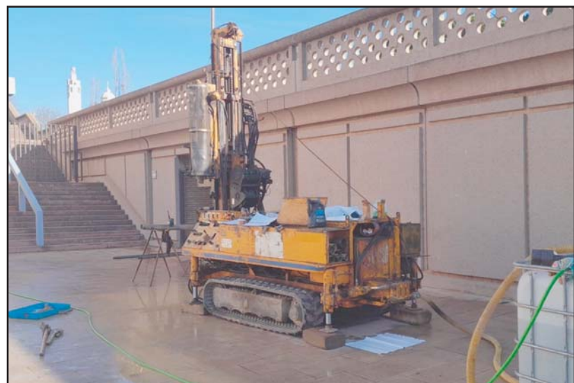
Fotografia 1. Vista de l'emplaçament de la màquina per a la realització del sondeig a rotació amb bateria continua S-4.
