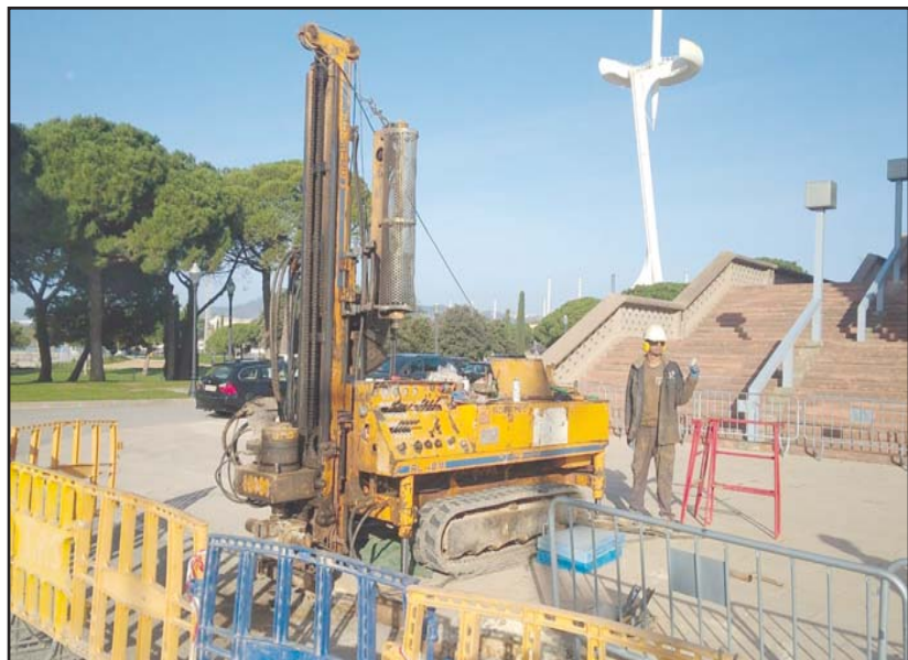
Fotografia 1. Vista de l'emplaçament de la màquina per a la realització del sondeig a rotació amb bateria continua S-2.
